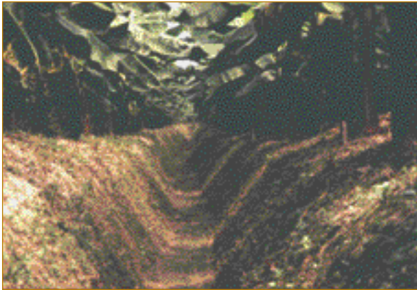
Figura 2. Drenaje primario o canal principal
